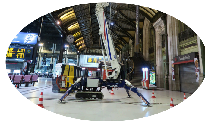
INSPECTION DÉTAILLÉE À PARIS GARE DE LYON
