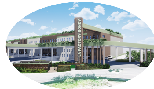
RÉDACTION DE DCS ET NSF POUR LA DÉMOLITION ET LA CONSTRUCTION D'UN HÔTEL D'ACTIVITÉ MULTINIVEAUX EN R+2 AVEC SOUS-SOL À BONDY
