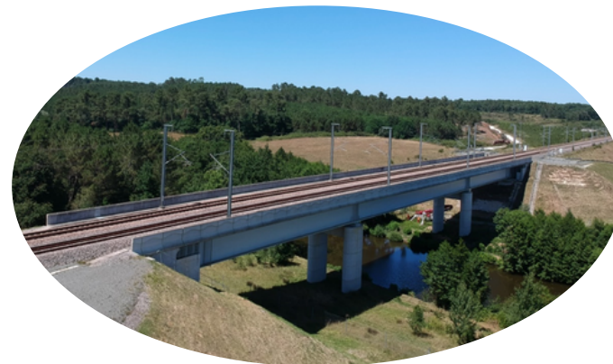
OUVRAGE D'ART NON COURANT - LGV SEA TOURS-BORDEAUX : VIADUC DE LA GOUJONNE
