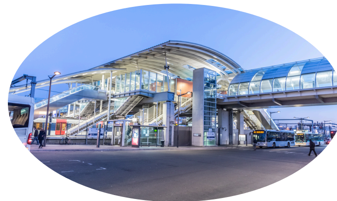
REALISATION D'UN DOSSIER PRO ET DCE POUR LA RÉPARATION DE LA PASSERELLE BOW-STRING DE LA GARE DE MASSY-PALISEAU SOUS CONTRAINTES D'EXPLOITATION SNCF & RATP
