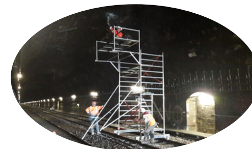
MISE EN PLACE DE CIBLES TOPO POUR LA SÉCURISATION DU TUNNEL DE MEUDON (92)
