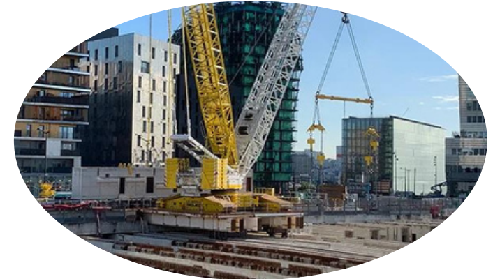
ASSISTANCE À MAITRISE D'OEUVRE DE LA SNCF POUR LA CONSTRUCTION D'UNE DALLE IMMOBILIERE AU-DESSUS DES VOIES FERRÉES À MASSENA (PARIS 13ÈME)
