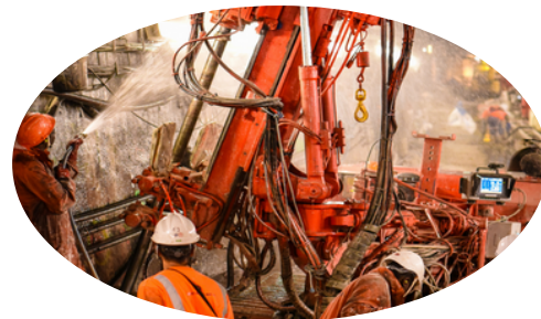
TRAVAUX DE JET GROUTING (RENFORCEMENT DU RADIER DU TUNNEL RER C)
